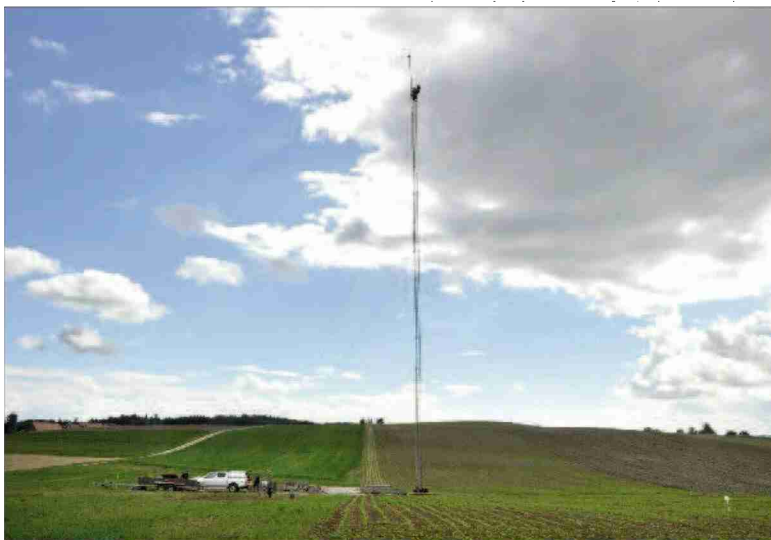
Un mât de 100 mètres a été installé à Bavois, en 2015, pour prendre des mesures du vent.
