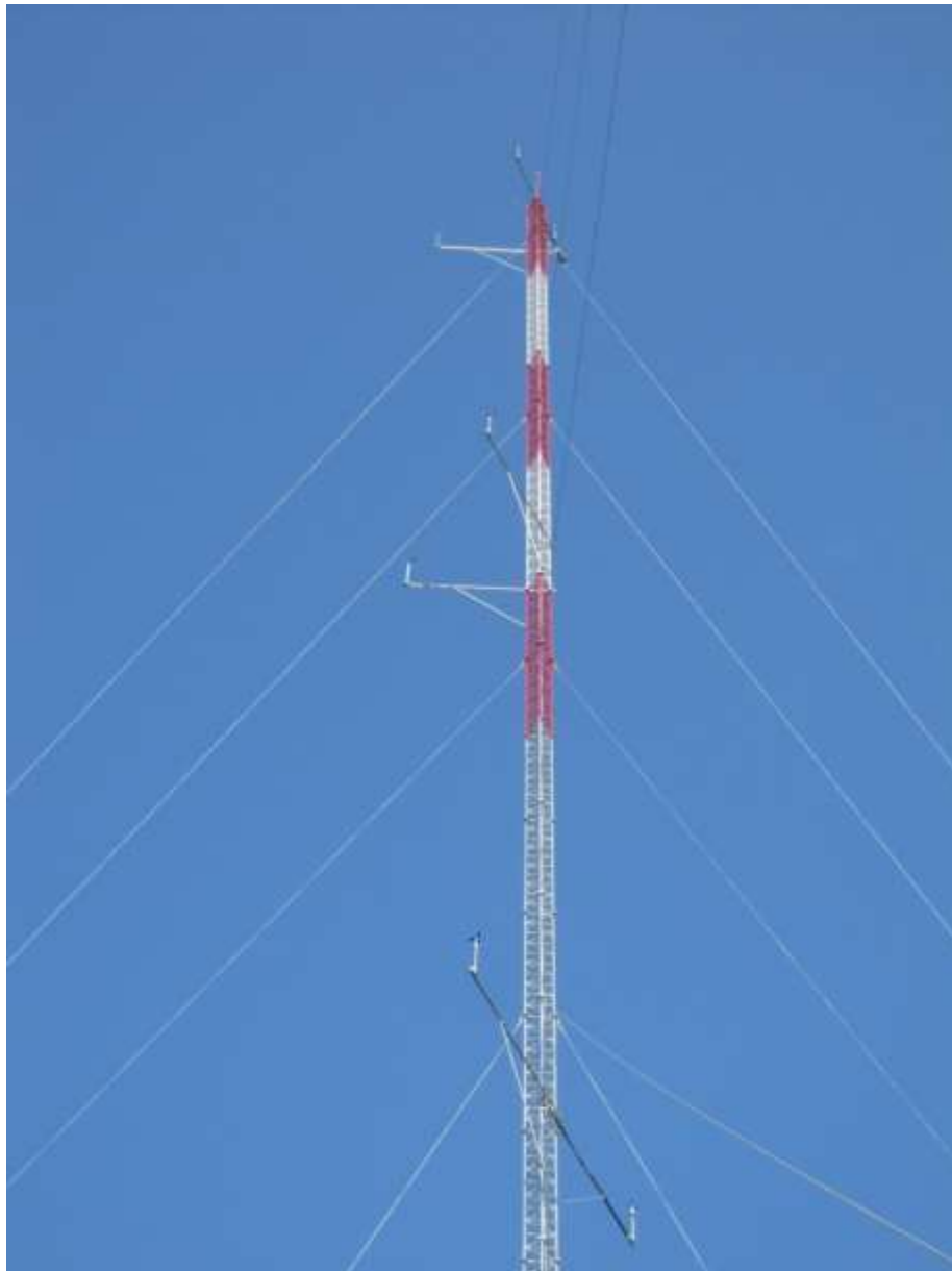
Sommet du mât de mesure avec les appareils de mesure du vent.
